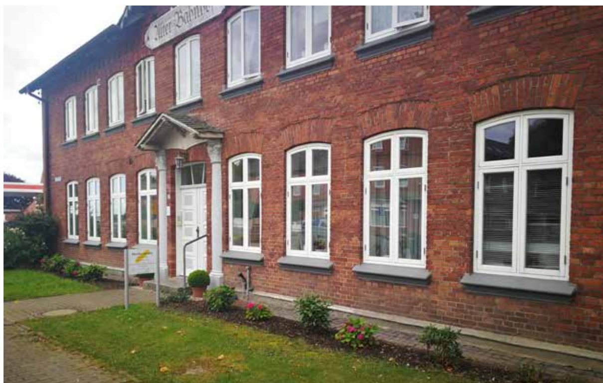
Abb. 10: Das ehemalige Bahnhofsgebäude
