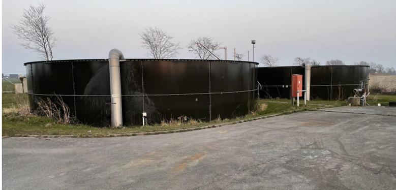
**Bild 4: SBR-Reaktoren**
