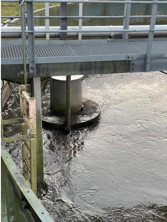
**Bild 9: Dekanter im Reaktor**
