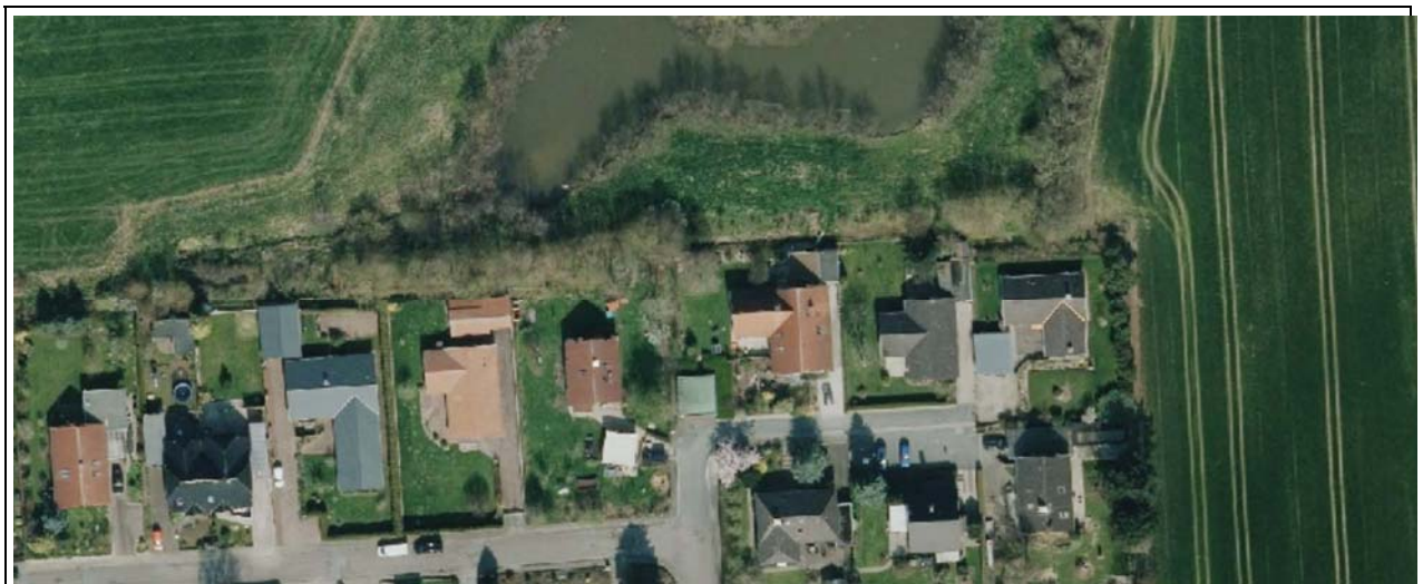
Abb.: Luftbild (Quelle: DA Nord)
