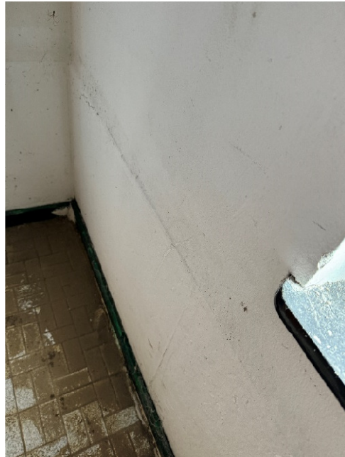
vorgesetzte Plattenverkleidung im Sockelbereich und Feuchtigkeitsspuren (12.06.2024)
