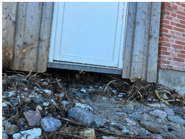
Schaden Eingangsbereich Anbau und fehlendes Fundament (16.05.2024)
