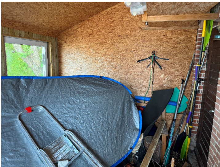
Anbau mit innerer OSB-Beplankung (12.06.2024)
