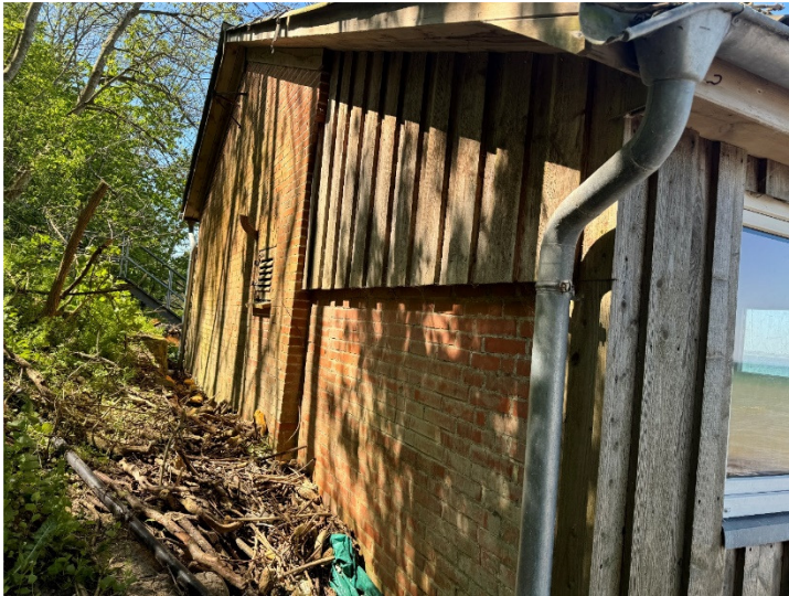
Rückseite Süden des Gebäudes am Steilufer (16.05.2024)
