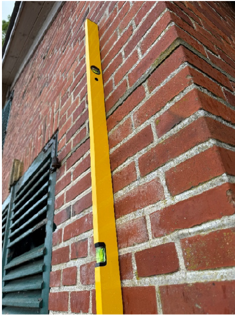
waagerechte und abgetreppte Fugenrisse und Lotüberprüfung an der Gebäudeecke – ohne Befund (12.06.2024)
