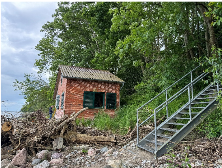
Traufansicht Westen mit Stahltreppe zum Steilufer (12.06.2024)
