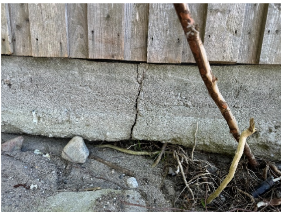
Gerisenes und freigespültes Trauffundament vom Anbau (16.05.2024)
