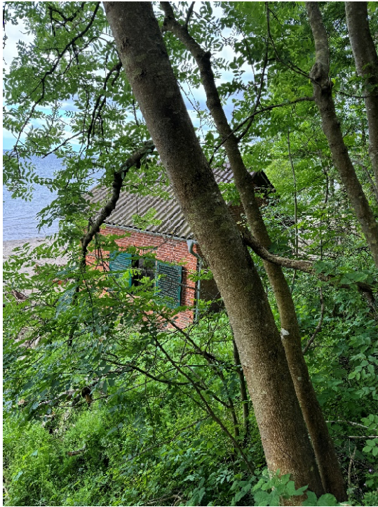
Blick vom Steilufer auf das Gebäude (12.06.2024)
