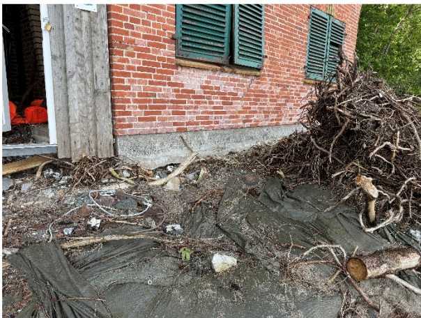
freigespülte Fundamente (12.06.2024)
