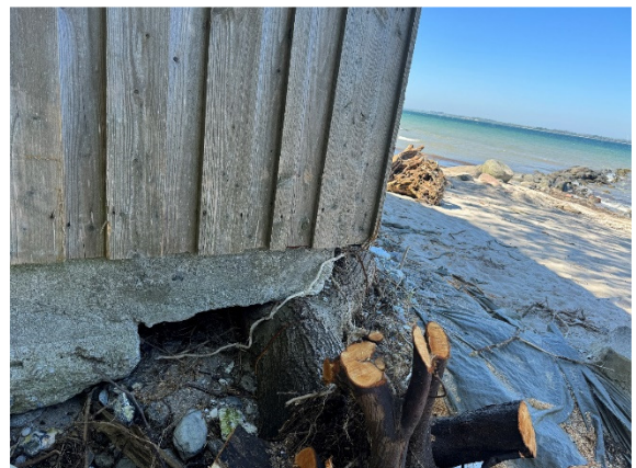
Gerisenes und freigespültes Trauffundament vom Anbau (16.05.2024)
