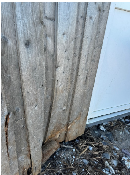
Schaden Eingangsbereich Anbau und fehlendes Fundament (16.05.2024)
