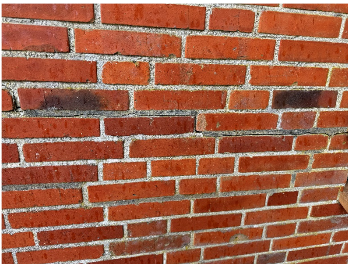
neue Rissbildung in vorheriger sanierter Lagerfuge (12.06.2024)
