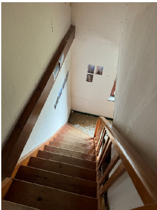
Treppe vom Dachboden (12.06.2024)
