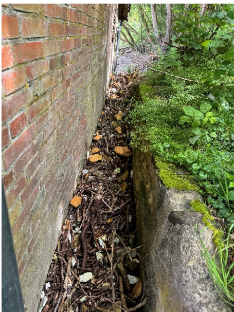
Stützwand zwischen Gebäude und Steilufer (12.06.2024)
