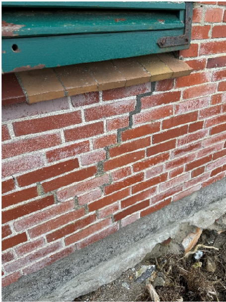
Ehemals ausgebesserte Risse in den Fugen am Nordgiebel (12.06.2024)
