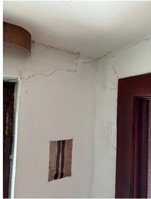
Risse im Innenbereich hier Sturzaufleger Giebelfenster Norden (12.06.2024)
