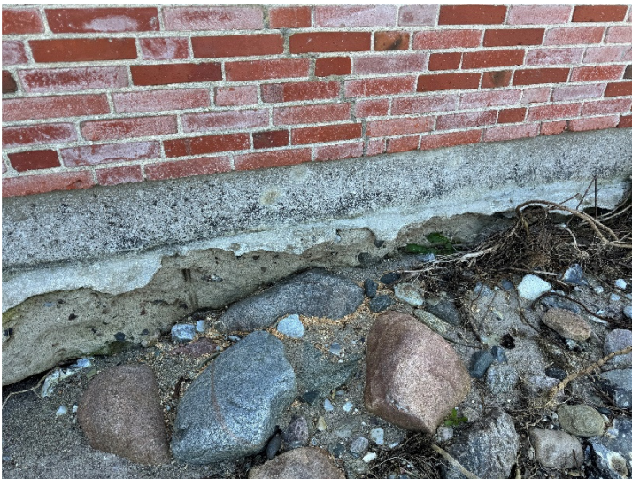
freigespültes Giebfundament Norden (16.05.2024)
