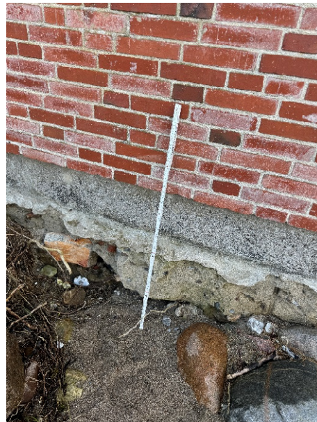
Ehemals ausgebesserte Risse in den Fugen am Nordgiebel (12.06.2024)
