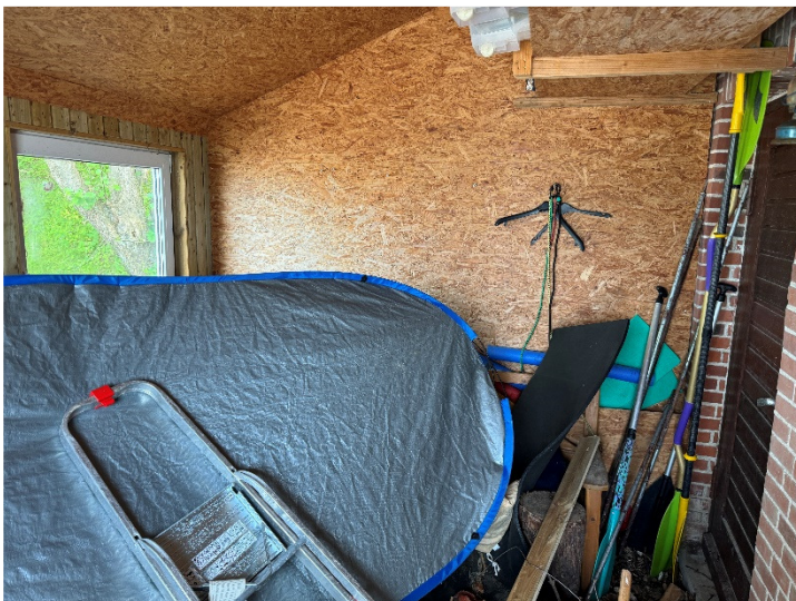
Anbau mit innerer OSB-Beplankung (12.06.2024)
