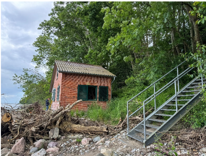
Traufansicht Westen mit Stahltreppe zum Steilufer (12.06.2024)
