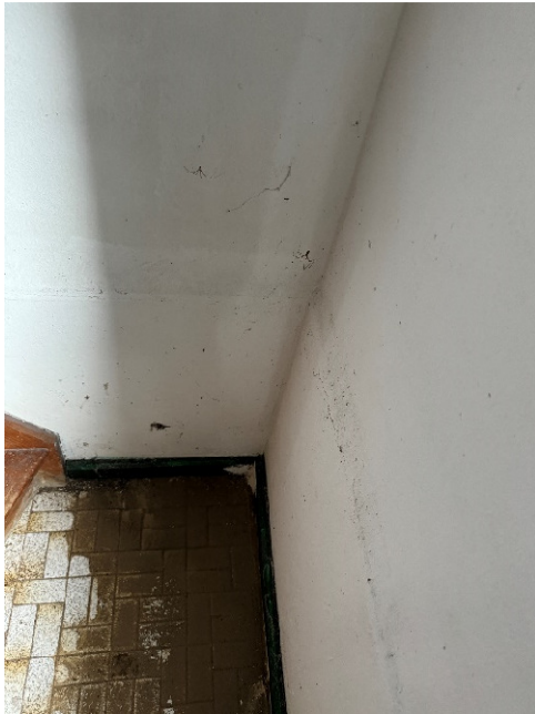
vorgesetzte Plattenverkleidung im Sockelbereich und Feuchtigkeitsspuren (12.06.2024)
