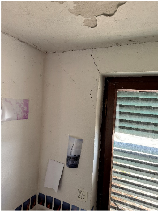
Risse im Innenbereich hier Sturzaufleger Giebelfenster Norden (12.06.2024)
