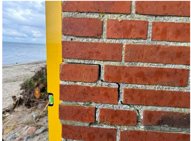
waagerechte und abgetreppte Fugenrisse und Lotüberprüfung an der Gebäudeecke – ohne Befund (12.06.2024)
